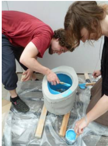
Abbildung 3: Anstreichen der selbst aus Beton gegossenen Kloschüssel
