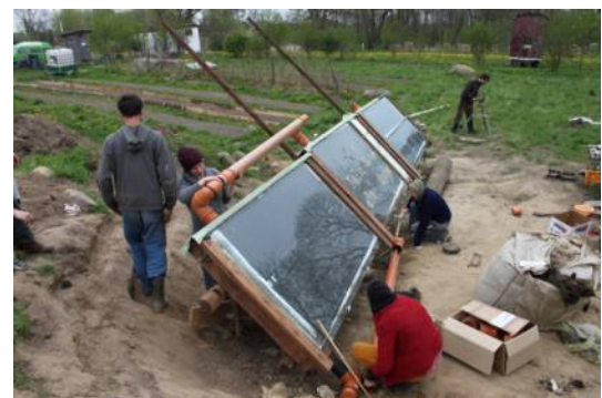
Abbildung 9: Bau der Kollektoren
