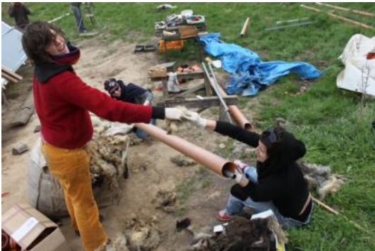
Abbildung 8: Isolieren der Rohre mit Schafswolle
