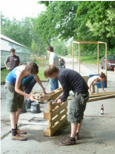
Abbildung 2: Bau des Toilettenhäuschens aus Altholz
